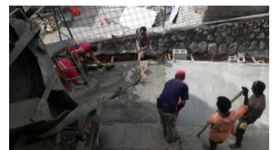
Männer vom Bau – Beton!
