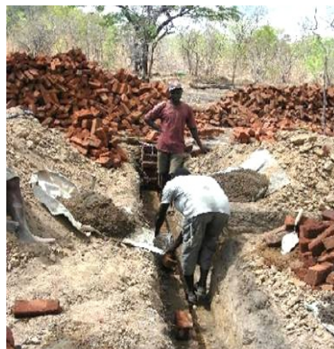
Mauern des Schulblock Fundamentes
