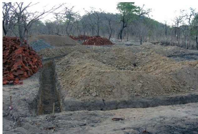
Ausheben des Schulblock Fundamentes
